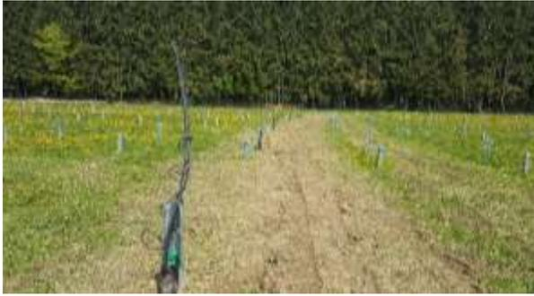
Abbildung 4: Verfüllter Kabelgraben
