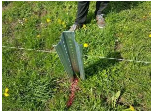
Abbildung 6: Rammfundament
